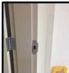
Un trou perforé dans pour insérer le loquet
